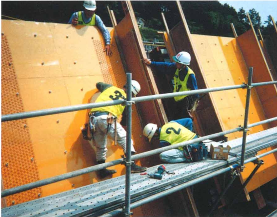
圧縮斜材への敷設作業
