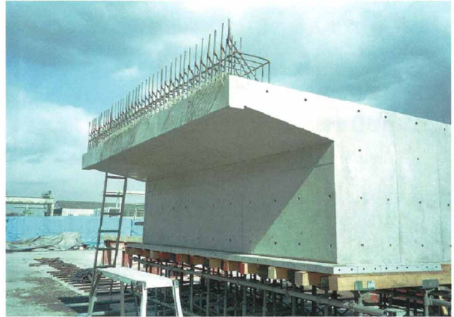
実物大施工：SAMM工法を適用したコンクリート部材
