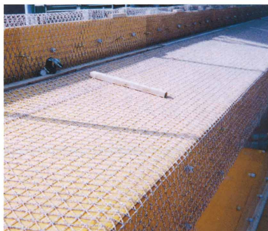
SAMMシート敷設状況(木製型枠)
